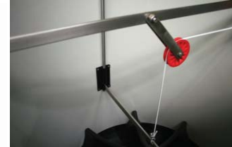
Zuluftverteiler von oben: Drahtseilführung über Seilrolle
